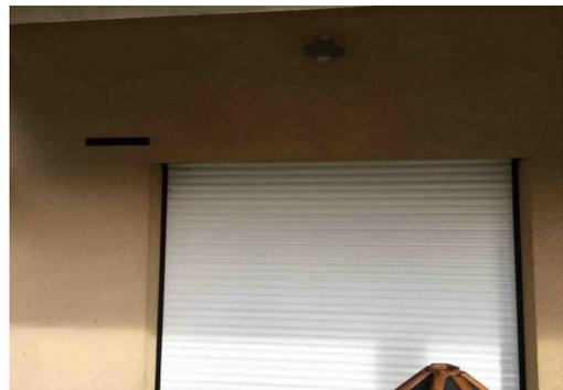
Le panneau n'a pas assez de luminosité pour garantir une charge convenable de la batterie (ombre visible) et surplomb beaucoup trop important.
