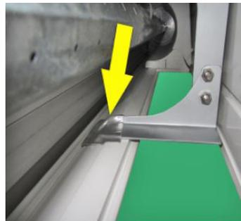
Étanchéifier le raccord entre la console statique et la planche de base à l'aide de l'adhésif en butyle fourni.
