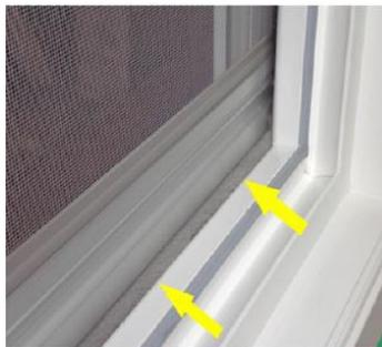
Le joint brosse doit être serré contre le dormant et la moustiquaire doit être uniformément tendue.
