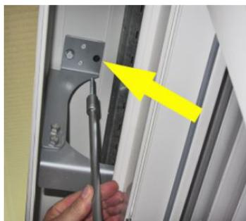
Fixer la console statique en utilisant les vis à clé adéquates.
