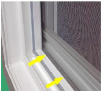
Le joint brosse de la lame finale doit être serré contre le dormant côté intérieur.
