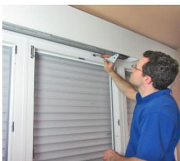
Insérer la partie inférieure de la console statique à travers la planche de base dans les renforts spéciaux en fer.
