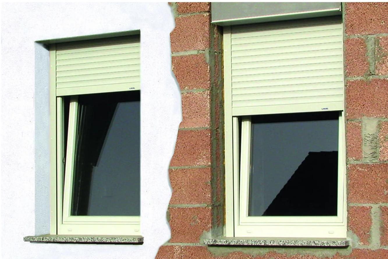
Der Rollladenkasten verschwindet ganz dezent unter dem Putz und ist später bequem über den unten liegenden Revisionsdeckel zugänglich. (Foto: © Lakal)
