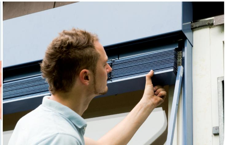
Anschließend muss der Stecker des Motors an die bauseitige Leitung angeschlossen werden, danach folgt die Montage der Führungsschienen. Dazu den Behang um 20-30 cm abfahren und die Metallstifte des Lamellenpakets in die Führungsschiene gleiten lassen.
