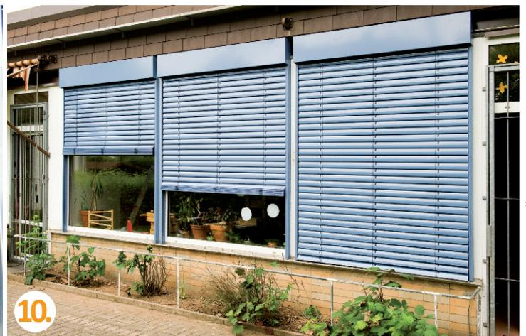
Abschließend ist eine Probefahrt nötig. Die Endlagen sind bereits eingestellt. Eine vollständige Probefahrt bedeutet: Alles zu 100% schließen und wieder ganz öffnen und fertig montiert ist der Raffstore.
