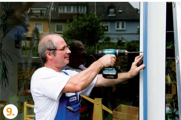
Nun die Führungsschienen an die Grundschiene anschrauben.
