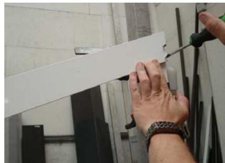
5. neues Seil von oben durch die Führungsschiene ziehen
