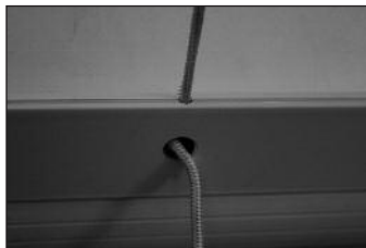
f Schnur durch Umlenkrolle am oberen Abschlusswinkel führen.
