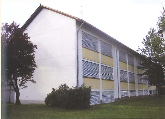
Schulgebäude vor der Sanierung
